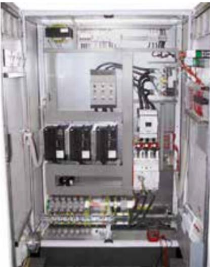
Mando de control con tiristores en funcionamiento de retraso de fase para regulación de potencia económica.
