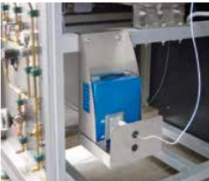
Bomba de ácido para ácido nítrico
