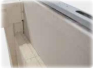
Estructura de aislamiento multicapa de ladrillos refractarios
